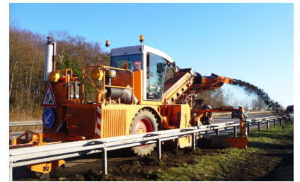
FRÄSEN UNTER SCHUTZPLANKEN
